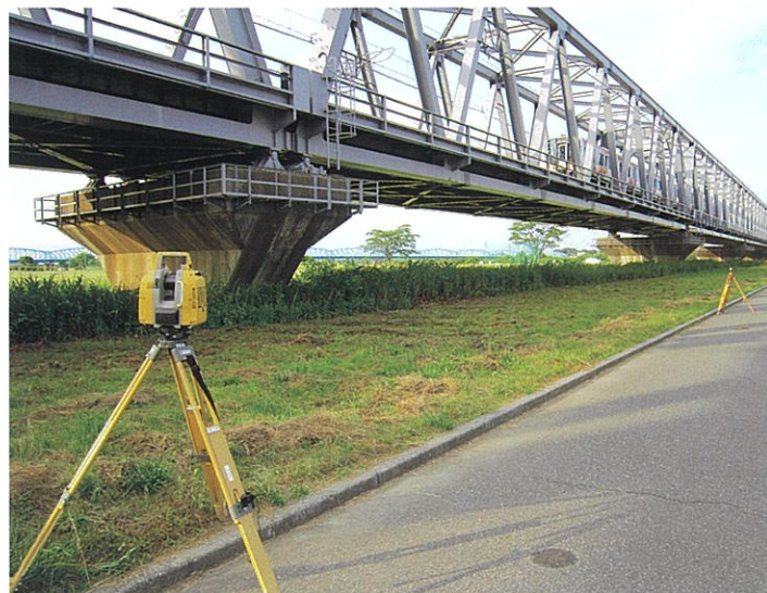
3Dレーザー測量
