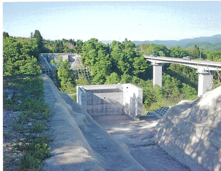
用地取得と物件の移転で、橋の架替工事が進む
