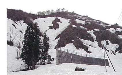
雪崩防護擁壁
